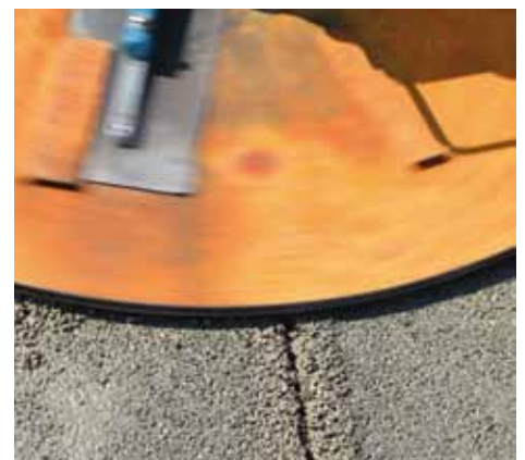
Wegwerken: Met de vlinderschijf wordt de insnijding weer keurig weggewerkt.
