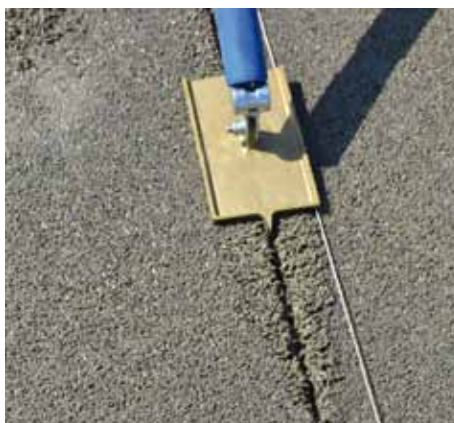
Insnijden: Aanbrengen van een breuklijn in de verse cementsplit.
