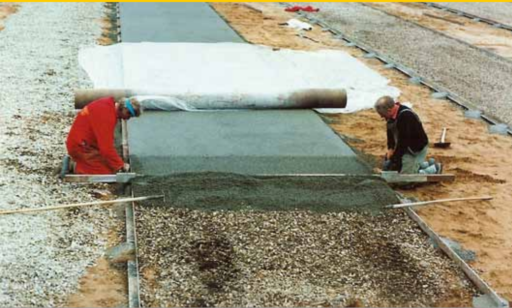
Aanbrengen van Kropor in zes stroken, gescheiden door een dilatatievoeg. Dit lijkt enigszins op Mateco, archiefphoto.
